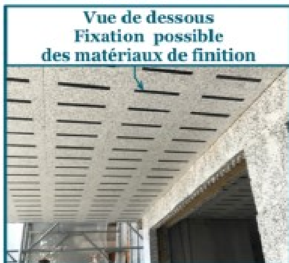
Coffrage périphérique de dalle du balcon
